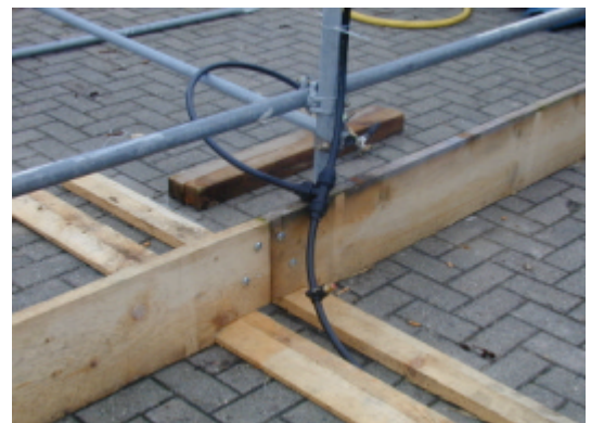
Bild oben: Detail Drakaschlauch, Nebeldüse, T-Stück
