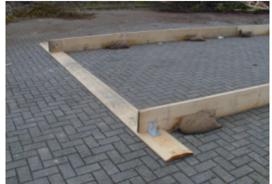
Bild oben: Zur Reifenschonung werden die Kanten der Bretter abgeschrägt (ca. 20 °)
