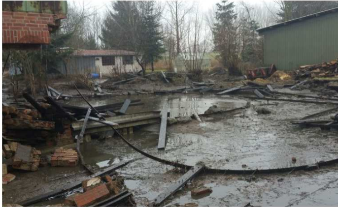
Geplatzter Güllebehälter in Strenglin (Schleswig-Holstein)
