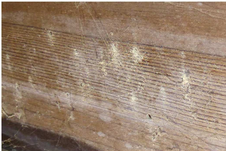
Bild 10: Binder 2 - Schlupflöcher holzerstörender Insekten.
